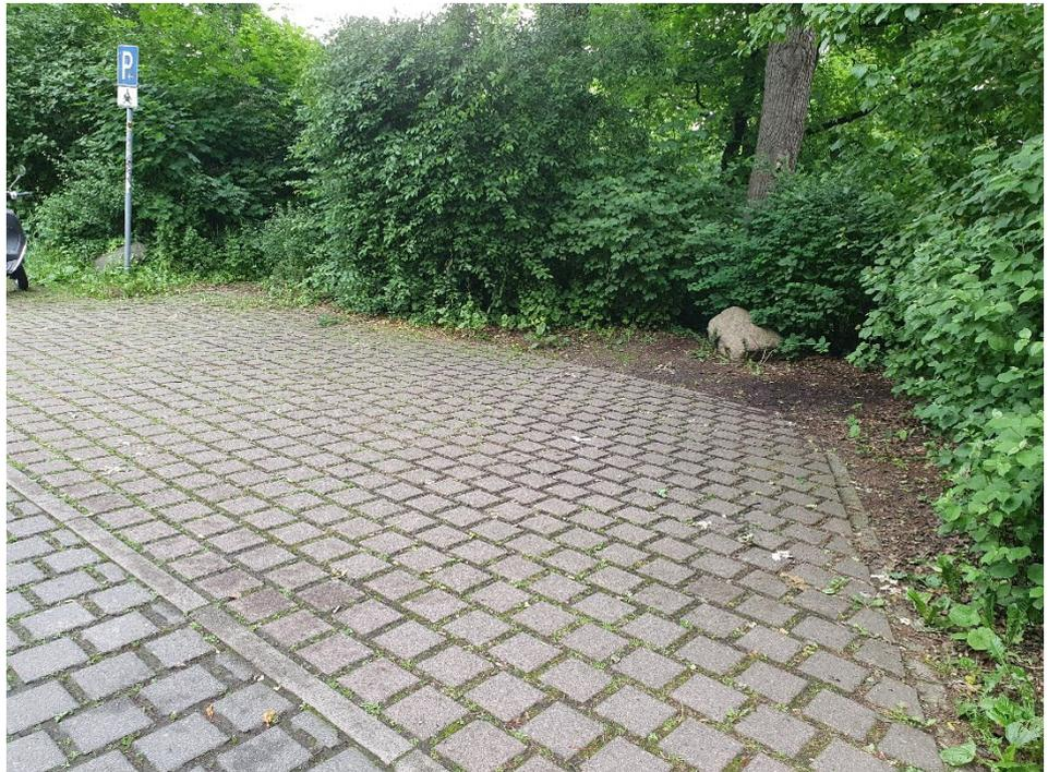
**Abb. 1: Beispiel einer Pflasterung mit breiten Fugen (Standort Bahnhof Lüneburg)**
