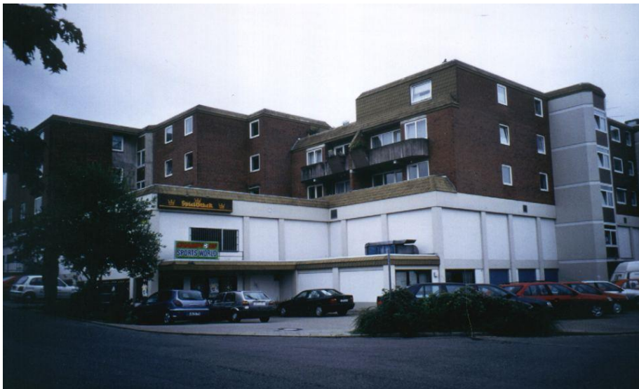
Bild 8: Nordost-Ansicht des Einkaufszentrums mit Eigentumswohnungen im Obergeschoß
