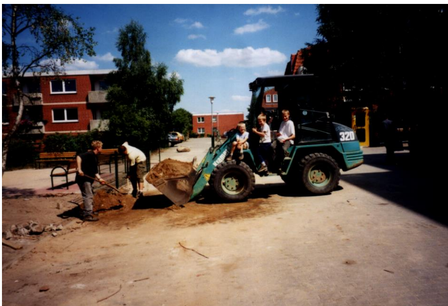
Bild 35: Bauarbei- ten am Spielplatz Wilhelm-Leuschner- Straße
