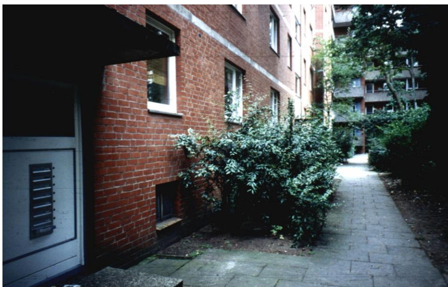
Bild 24: Eingangsbereich eines Gebäudes an der Theodor-Haubach-Straße
