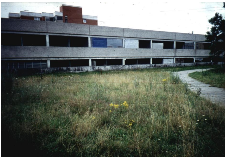
Bild 36: Ostansicht des Parkhauses Wilhelm-Leuschner- Straße
