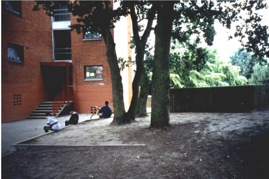
Bild 22: Eingangsbereich des Gebäudes des Graf-von-Moltke-Straße 3
