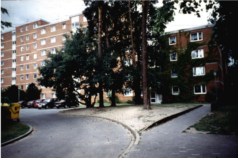
Bild 16: Einfahrt zum Parkplatz an der Bernhard-Letterhaus-Straße
