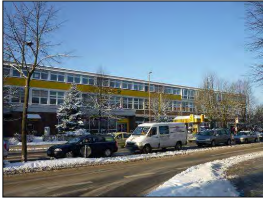
Foto: Postgelände aus östlicher Sicht
