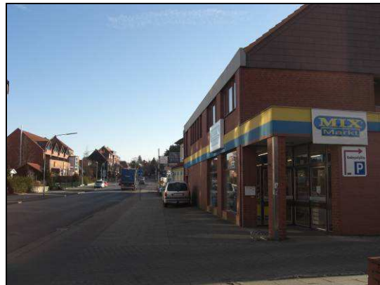
Foto: Mix Markt-Supermarkt im NVZ Dahlenburger Landstraße
