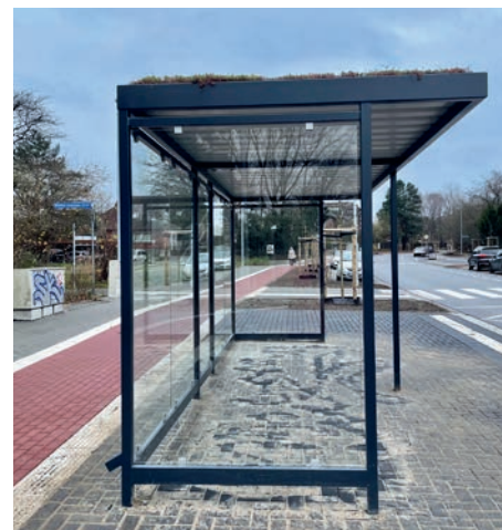
Lüneburgs erste Bushaltestelle mit Gründach und PV-Anlage steht in der Wilhelm-Leuschner-Straße.
