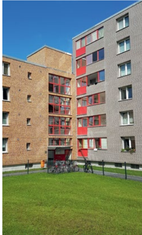
Am Weißen Turm nach der Sanierung
