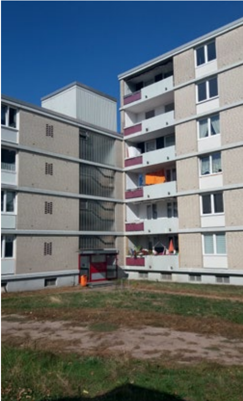
Am Weißen Turm vor der Sanierung
