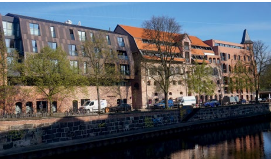
Viskulenhof nach der Sanierung
